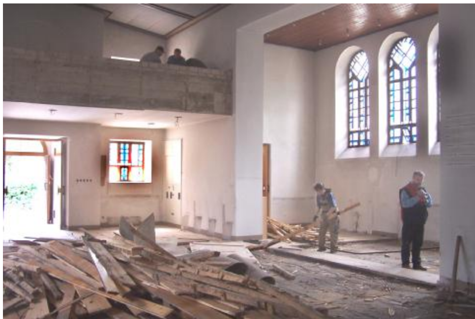
Abriss des Holzfußbodens
