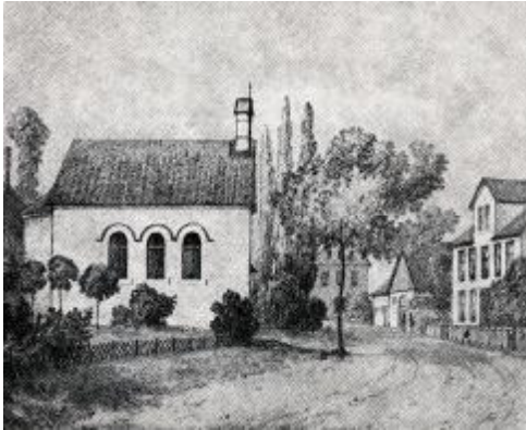
Kirche von 1846 an der Detmolder Straße
