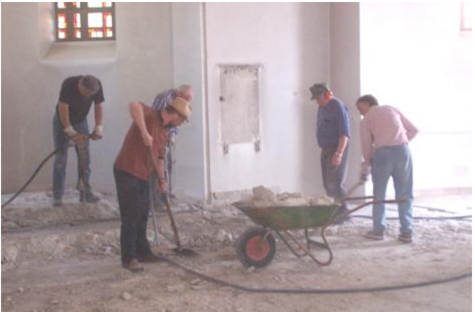
Entfernen des Betonsockels – Heinz Kehne, Martin Gasse, Heinz Ciesla, Kurt Oberschäfer
