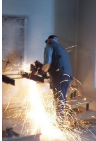
Fritz Gasse beim Abflexen
