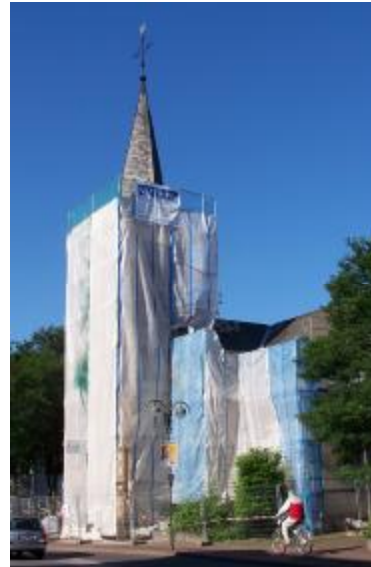
Eingerüsteter Turm während der Bauarbeiten 2004
